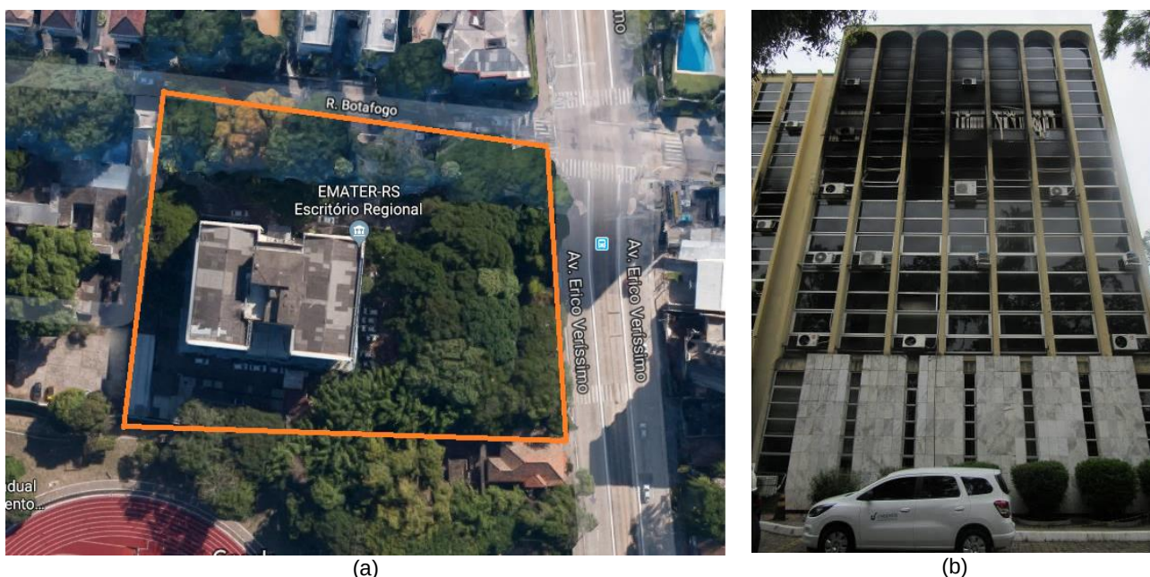
Figura 1 – (a) Imagem aérea do terreno onde a edificação está implantada (Google Maps, 2018) e (b) vista da fachada frontal da ala oeste
