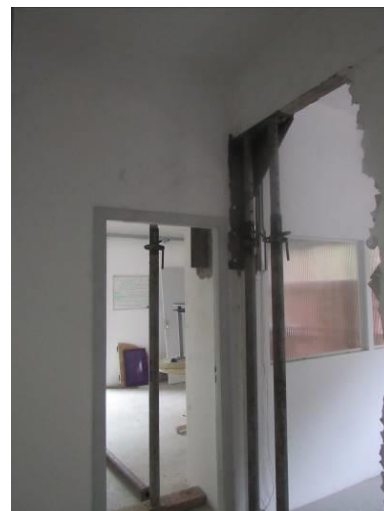
Figura 5 – Imagens registradas no terceiro pavimento da edificação: (a) marcas de escorrimento entre a laje e a viga; e (b) escoramento do pilar P45
