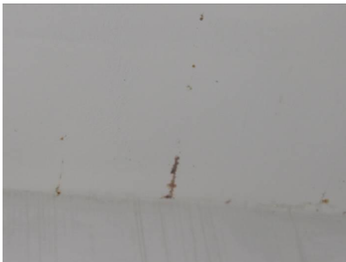
Figura 5 – Imagens registradas no terceiro pavimento da edificação: (a) marcas de escorrimento entre a laje e a viga; e (b) escoramento do pilar P45
