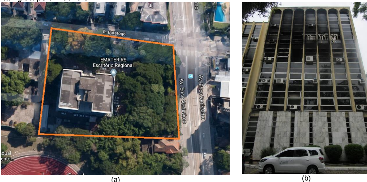
Figura 1 – (a) Imagem aérea do terreno onde a edificação está implantada (Google Maps, 2018) e (b) vista da fachada frontal da ala oeste após incêndio
