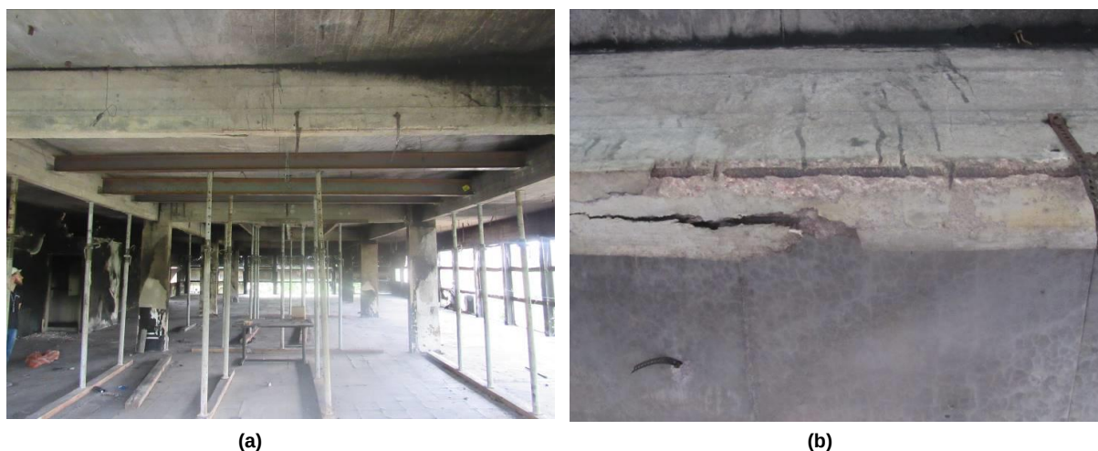
Figura 10 – Deslocamento do concreto na região de cobrimento da armadura da viga (a) V51 e (b) V53, (c) detalhe do rompimento da armadura longitudinal inferior da viga
