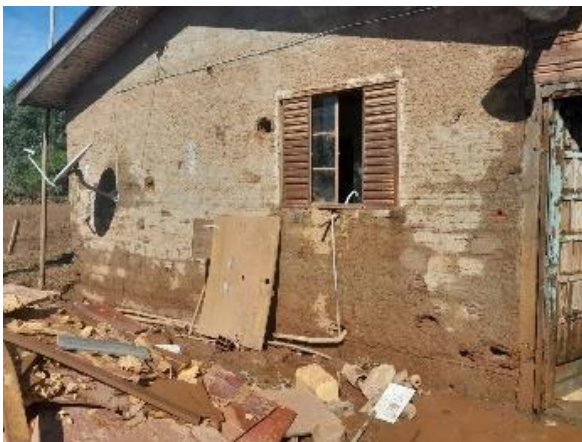
Foto 1 - Moradia do Assentamento Tempo Novo no município de Taquari, Regional de Lajeado
