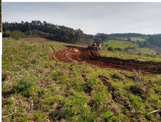
Construção de terraços em propriedade, em Herveiras (dezembro/2025).
