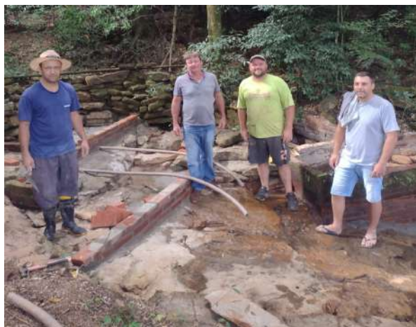
Proteção da nascente em Herveiras (dezembro/2025).
