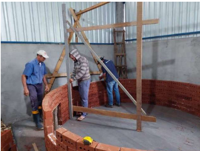
Construção Silo Secador, capacidade de 300 sc., em Dois Lajeados (abril/2023).
