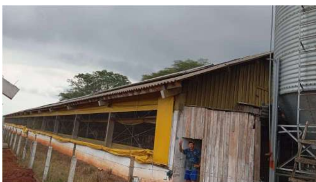
Instalação de sistema de energia solar fotovoltaica em propriedade, em Fazenda Vila Nova (novembro/2025).
