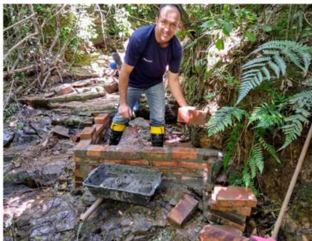
Execução do trabalho de construção de proteção da nascente, em Herveiras (dezembro/2025).
