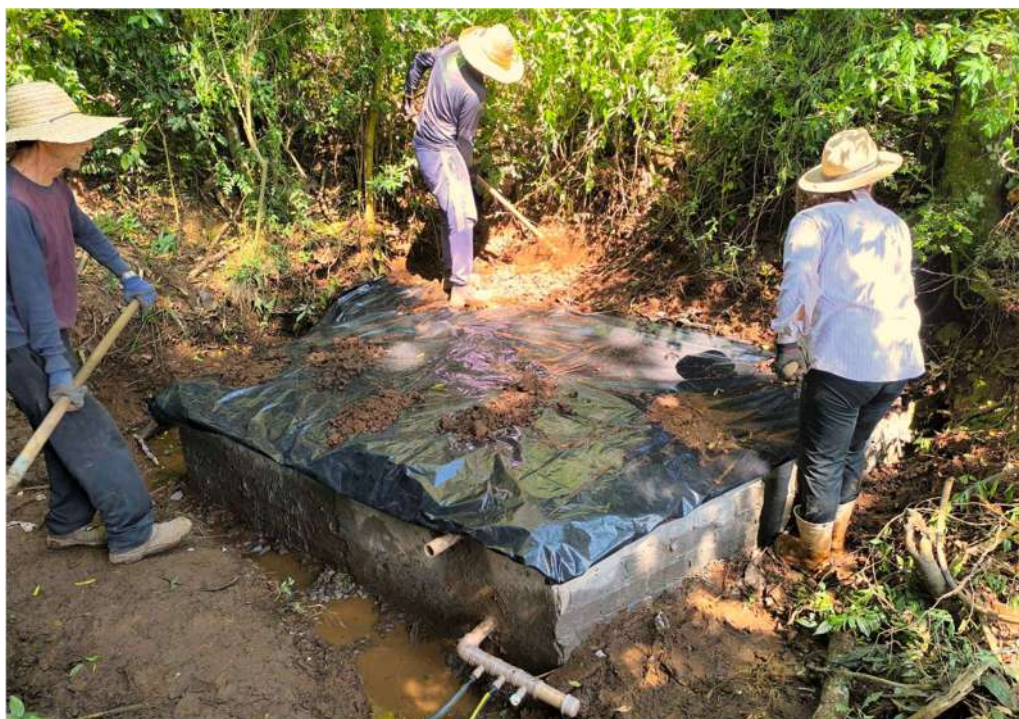
Depois: processo de cobertura da proteção da nascente na unidade produtiva do agricultor Michel, em David Canabarro (novembro/2025).
