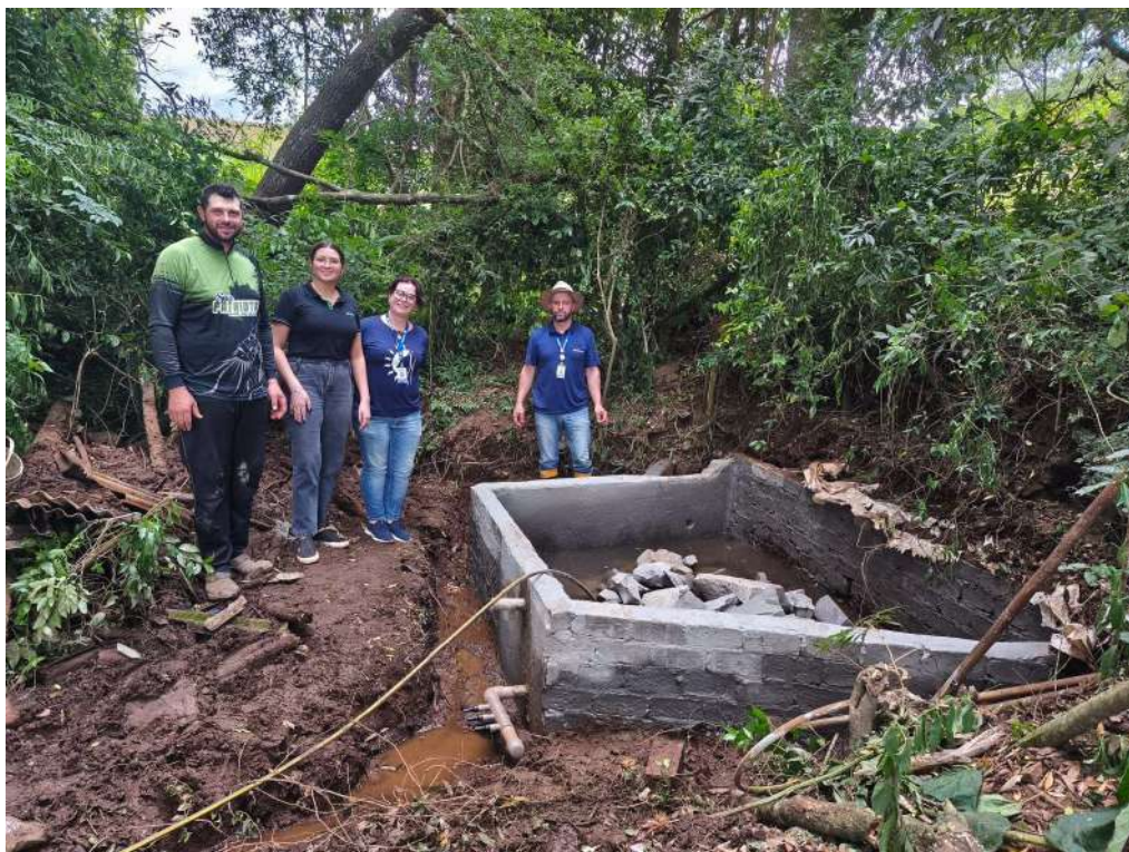
Durante: processo de construção da proteção da nascente na unidade produtiva do agricultor Michel, em David Canabarro (novembro/2025).
