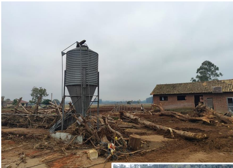
Destruição de infraestruturas pela força da torrente, em Venâncio Aires (maio/2024).
