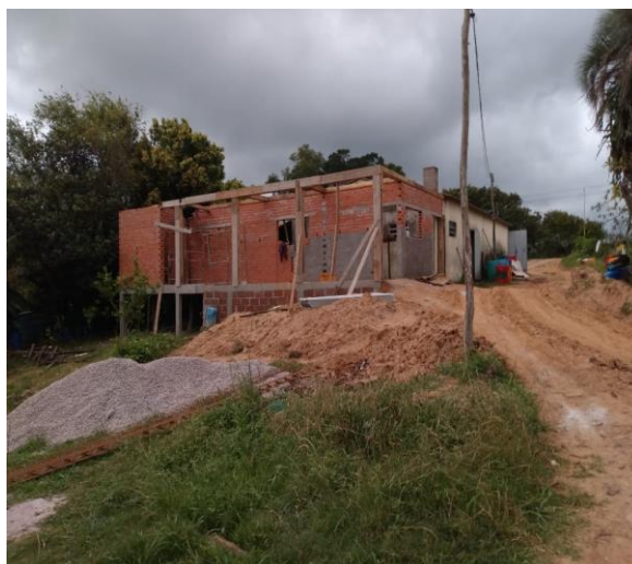
Acompanhamento e orientação para finalização da execução das obras de adequação sanitária da agroindústria (fevereiro/2024).
