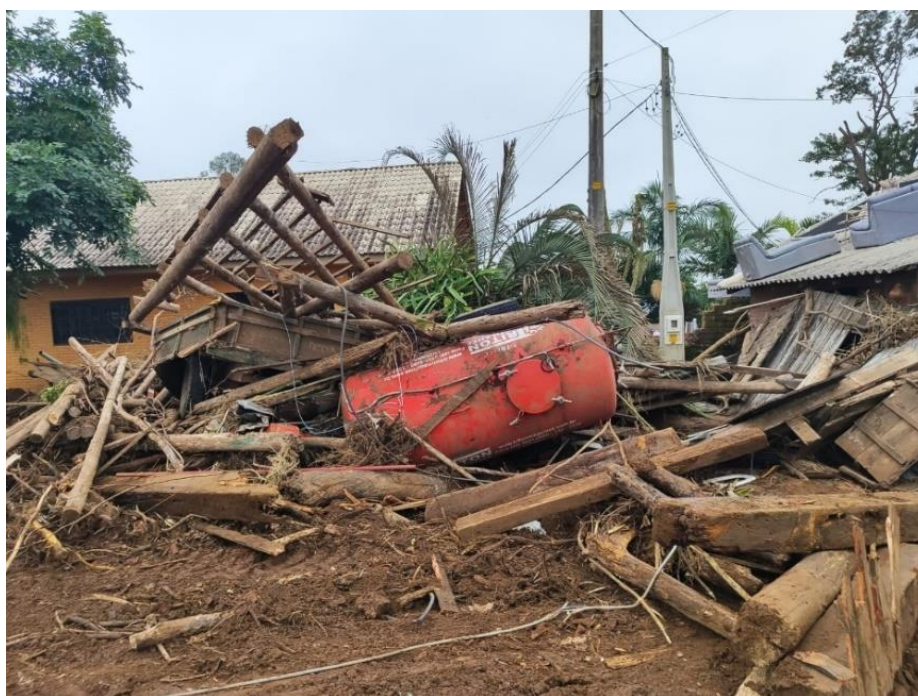
Destruição de infraestruturas pela força da torrente, em Venâncio Aires (maio/2024).
