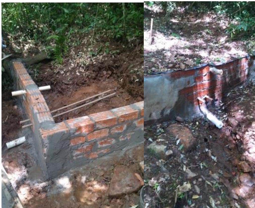
Estrutura de proteção (outubro/2024).
