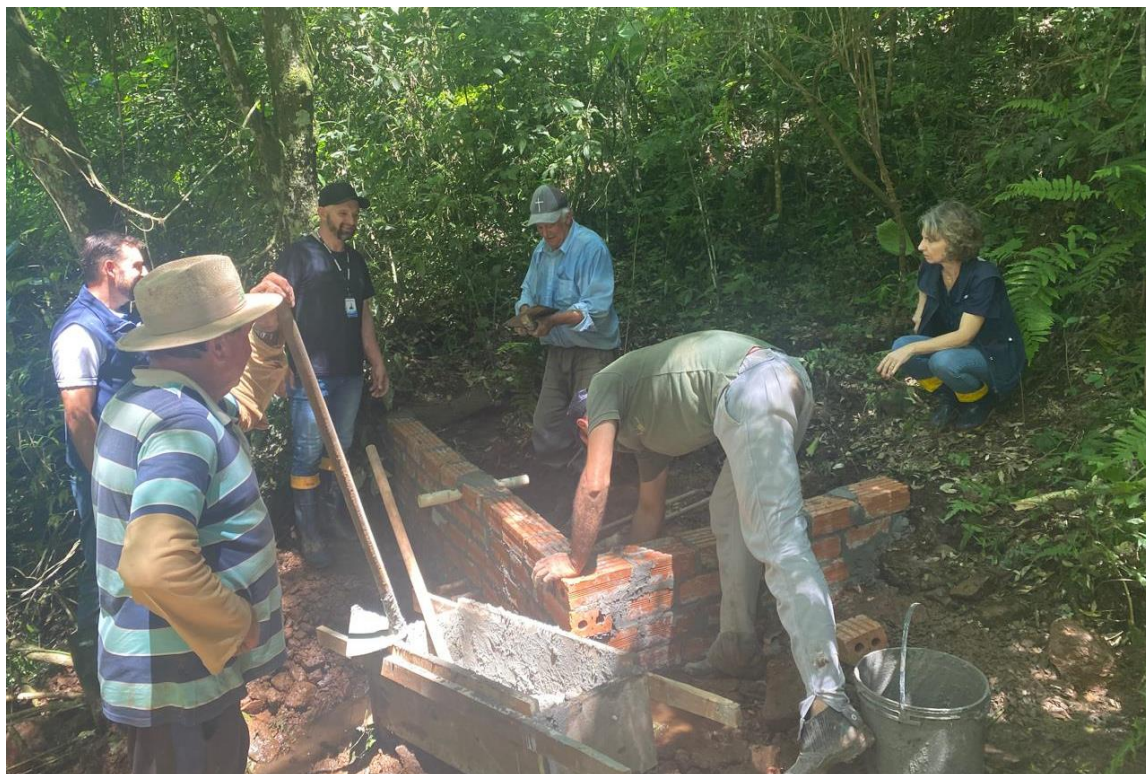
Construção da estrutura de proteção/filtro (outubro/2024).
