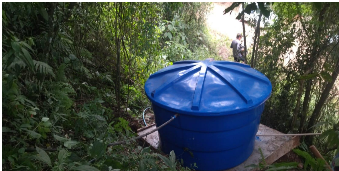
Instalação de reservatório para utilização da água pelas famílias (novembro/2024).
