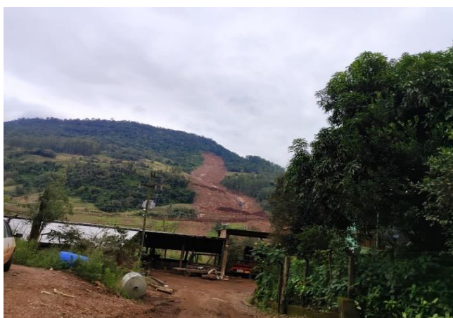
UPF destruída por deslizamento em Muçum (maio/2024).
