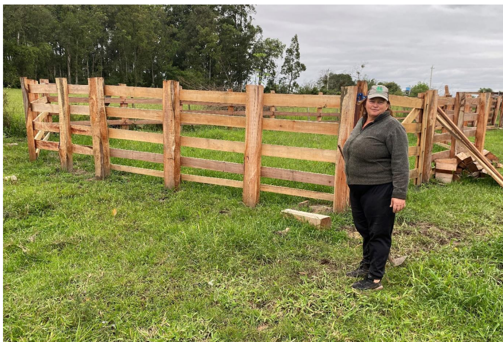
Mari Lenir Poche na construção do centro de manejo para o rebanho bovino, em São Vicente do Sul (outubro/2024).
