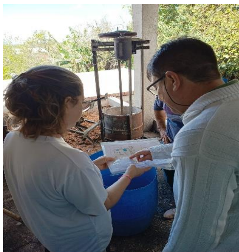
Acompanhamento e orientação na execução das obras de adequação sanitária da agroindústria (novembro/2023).
