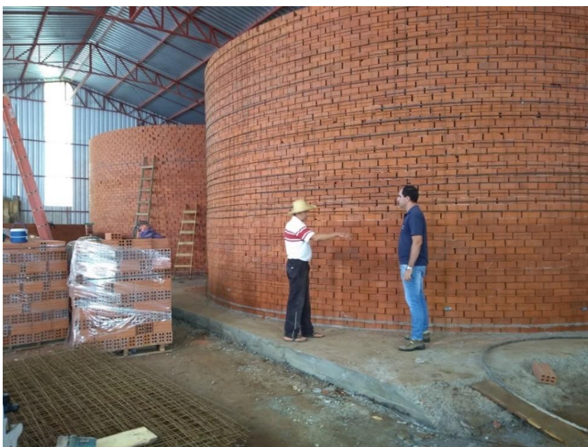
Construção de silo armazenador de Alceu Primel, em Santo Antônio do Palma (outubro/2022).
