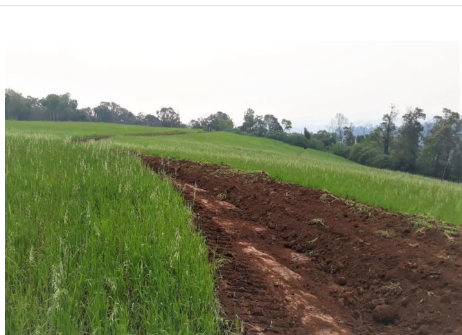
Manejo do solo - locação e construção de terraços, em Veranópolis (novembro/2022).
