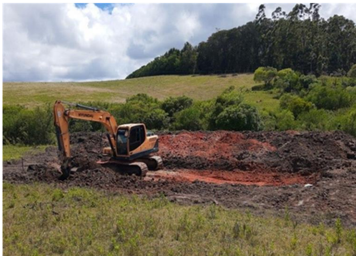
Construção de Viveiros para Piscicultura, Aceguá (12/2021).
