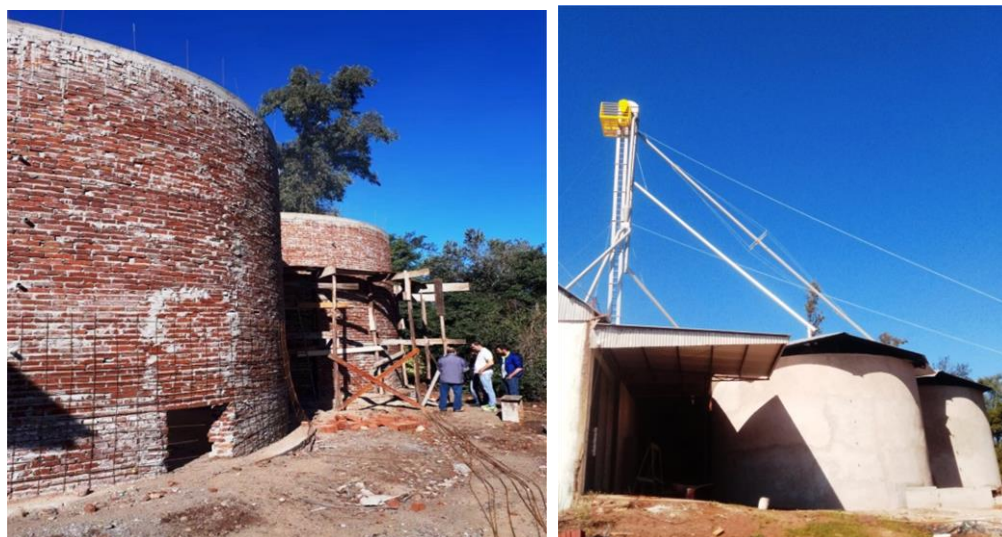
Construção do silo secador na Coopax em Porto Xavier.
