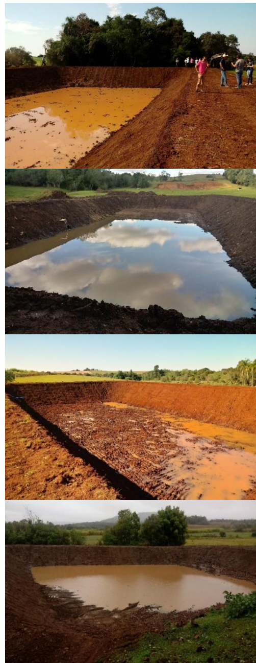
Açudes sendo construídos.
