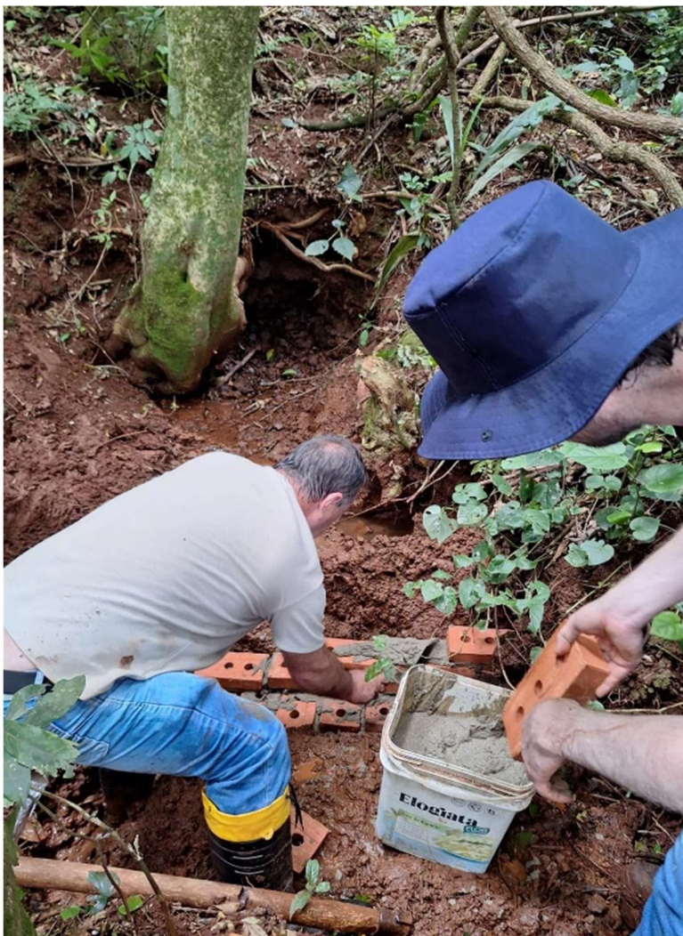
Proteção de Fonte em Bozano (novembro/2025).
