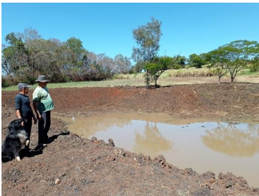
Viveiro para piscicultura em construção, propriedade de Ademir Buscholz, Ubiretama (02/2022).
