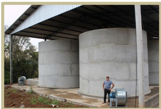
Instalações para secagem e armazenagem de grãos (Serafina Corrêa, setembro/2021).
