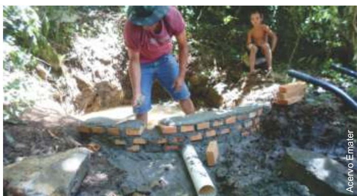
Construção de proteção para fonte
